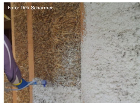
Putzaufbringen auf eine strohgedämmte Wand
