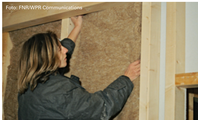
Foto: FNR/WPR Communications Einbau einer flexiblen Dämmmatte aus Hanffasern
